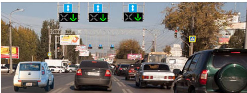
На проезжей части соответствующая разметка (сдвоенные прерывистые линии с длинными штрихами), а над полосами, выделенными для реверсивного движения, висят реверсивные светофоры.
